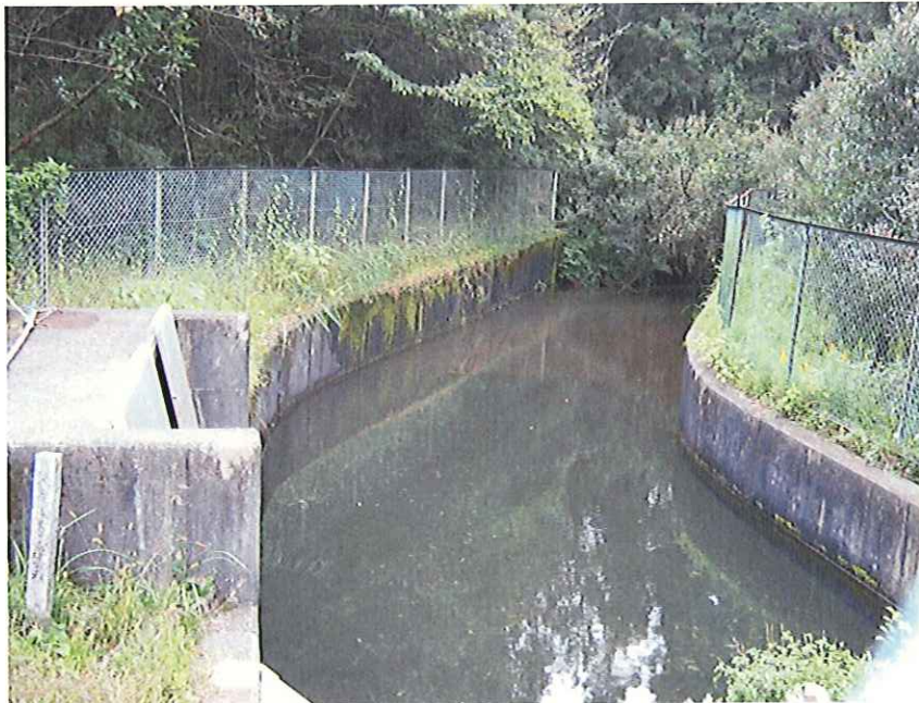
写真—5 関山用水取水口
