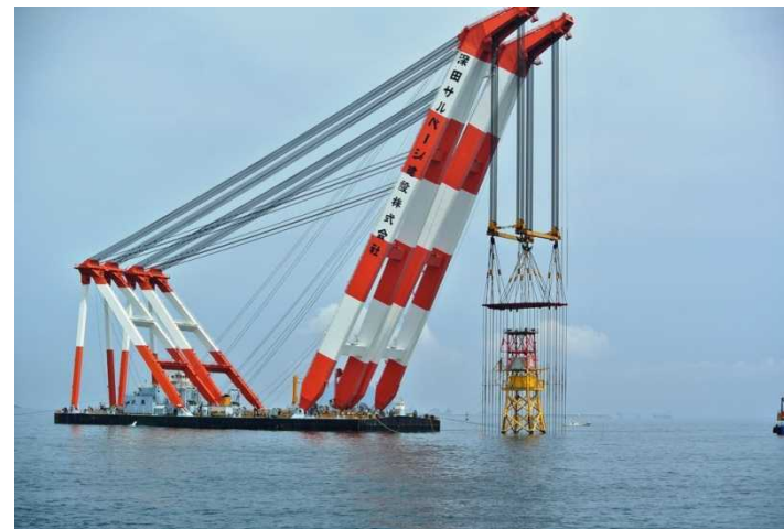
海上輸送・据付(起重機船3700t)
