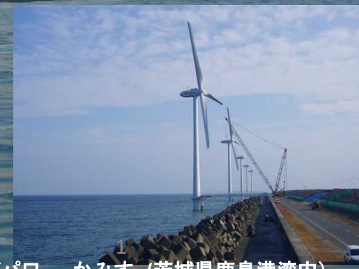
1 ウィンドパワー かみす (茨城県鹿島港湾内)
