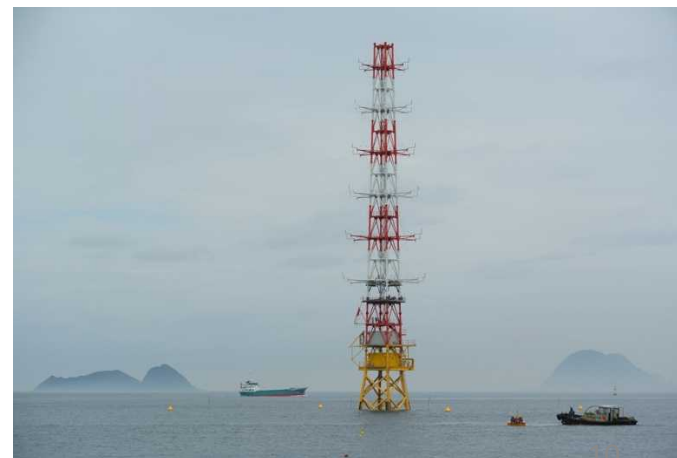
観測塔本体設置完了
