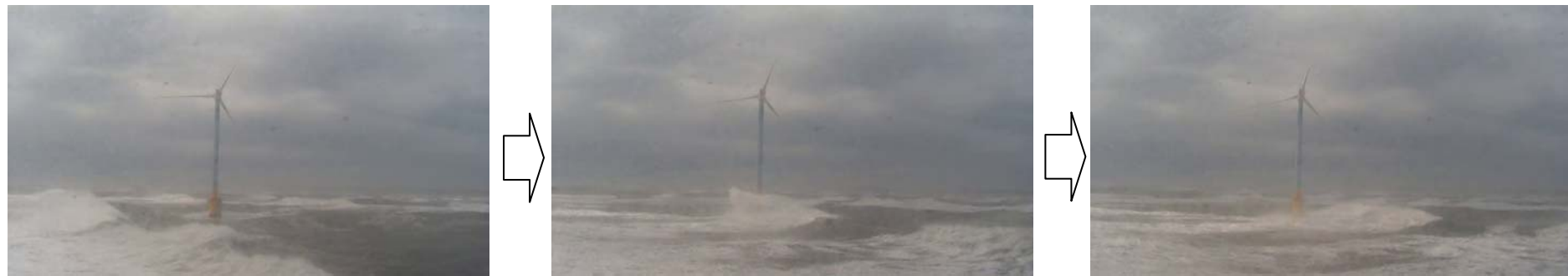
台風1326号による砕波波力の作用例（平成25年10月16日午後0時10分ごろ） （観測タワーに設置した遠隔監視カメラによる画像）
