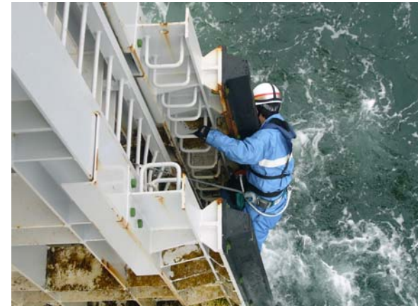
防舷材の補修
