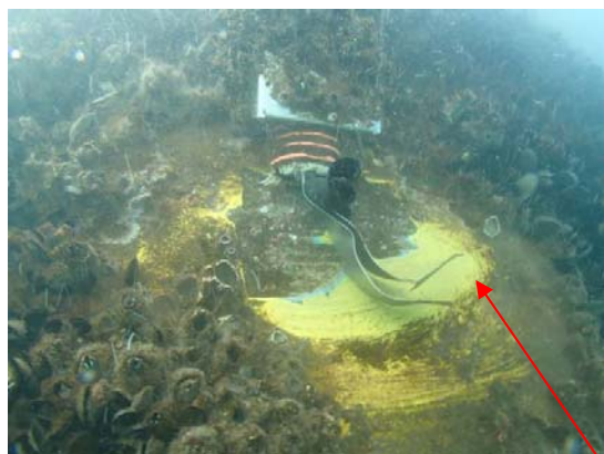
接地線の切断※ (上端部)
