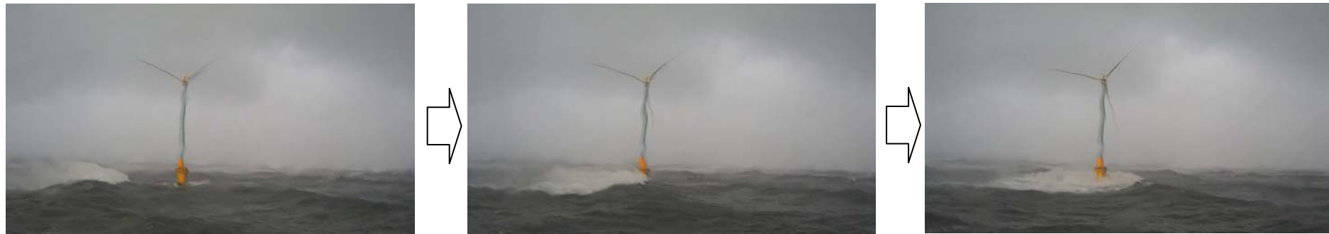
台風1326号による砕波波力の作用例（平成25年10月16日午前7時50分ごろ） （観測タワーに設置した遠隔監視カメラによる画像）
