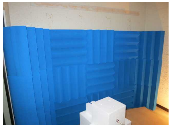
図18 送信アンテナ後方壁面のTUA-13B配置写真
