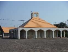
⑳真亀川総合公園 内レストラン棟
