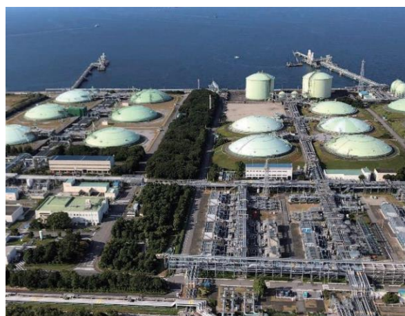
写真 4-2-3 袖ヶ浦 LNG 基地 出典 東京ガス(株)
