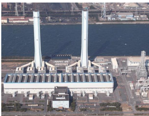
写真 4-2-2 千葉火力発電所 出典 (株)JERA
