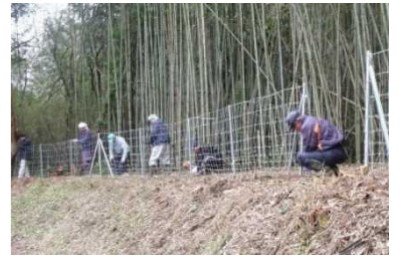
防護柵の設置
