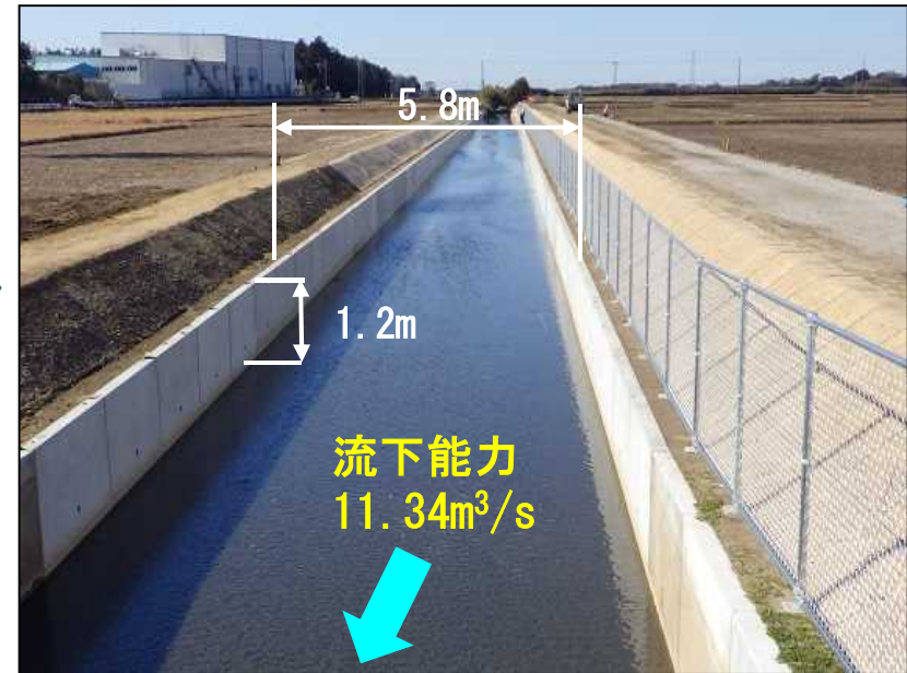
幹線10号Ⅱ型排水路 整備後
