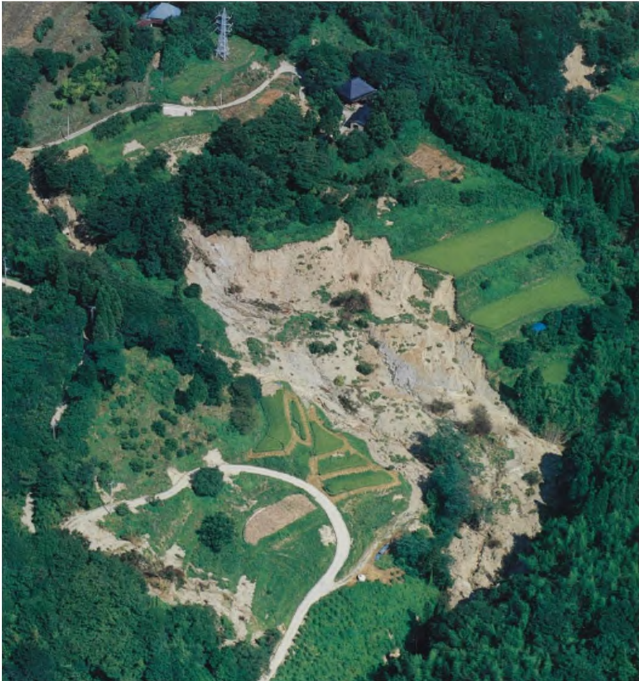
平成元年 鋸南町小保田北地区の大規模地すべり
