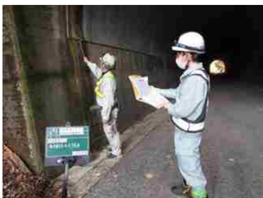
林道のトンネル点検
