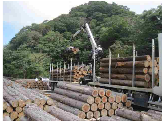
運搬トラックへの積込作業
