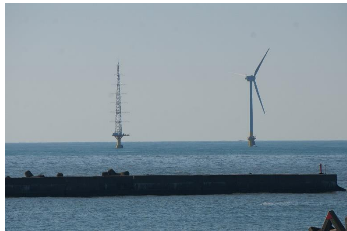
洋上風力発電施設
