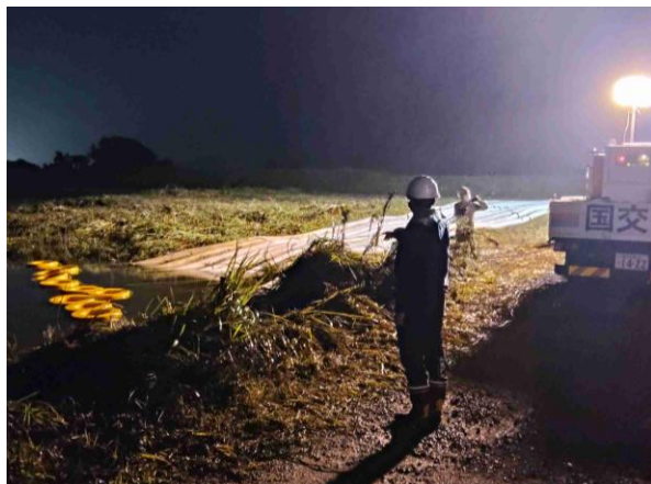
印旛沼周辺の浸水区域における排水作業
