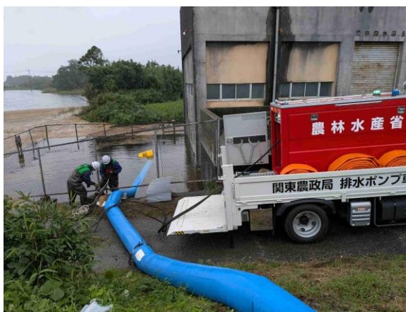
浸水した排水機場の復旧に向けた排水作業（茂原市）
