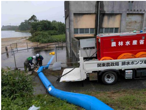
浸水した排水機場の復旧に向けた排水作業の様子（茂原市）
