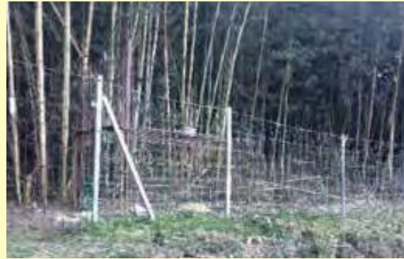
侵入防止柵と箱わな
