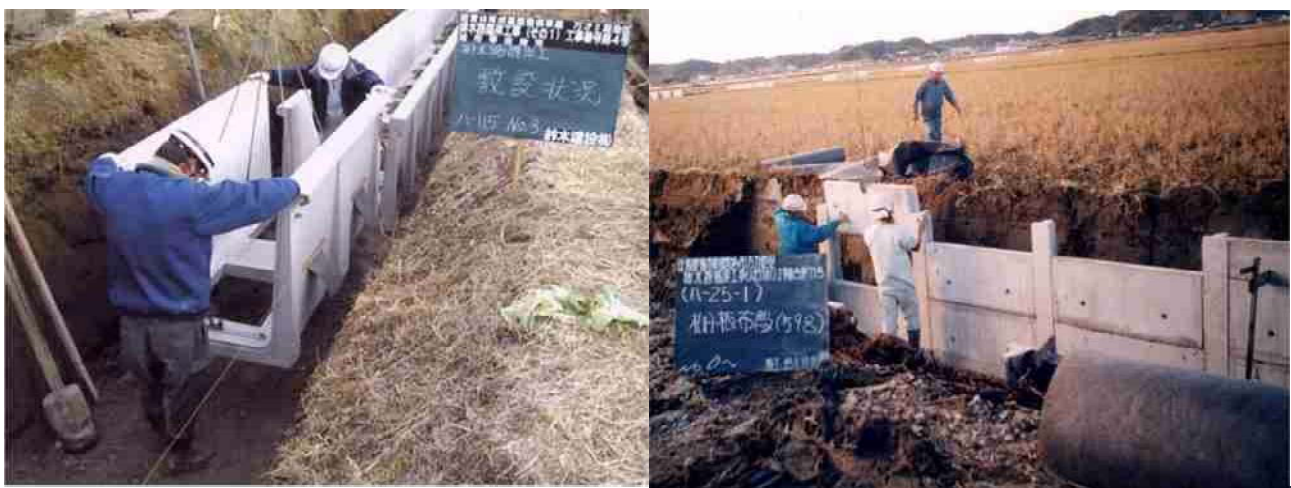
図2 二面水路とB型栅渠の施工状況
