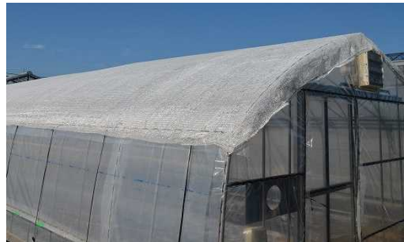
図4 外張りによる遮光ネットの利用
