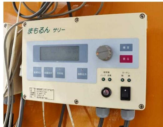
写真5 「まもるんサリー」 カーテン開閉機、暖房機に接続する PCに接続すれば環境モニタリングも可能
