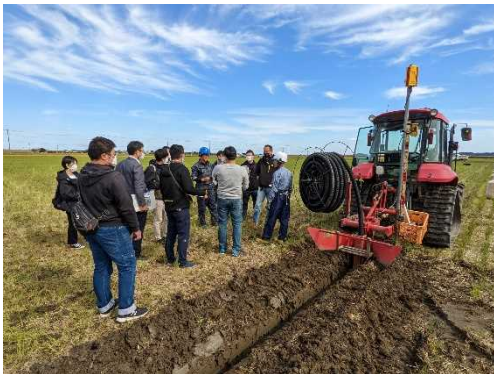
GPS制御で正確な暗渠を施工
