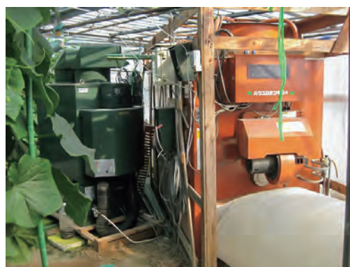
写真1 炭酸ガス発生器(左)の吹き出しをハウス加温機(右)の吸気口に向けて施用する
