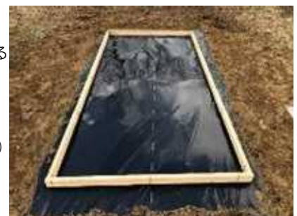
写真3 黒マルチ、木枠を施工した様子（この上に農業用ポリシートを敷く）
