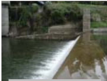
養老川 日竹貯砂ダム魚道
