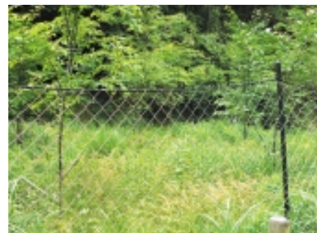
ネット防護柵
