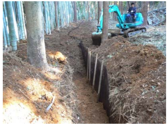
遮蔽板（波板）を使った拡大防止方法
