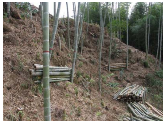
伐採した竹材を使用して斜面の浸食防止
