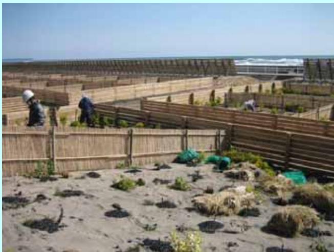
かいがん すな かいりよう ちから 海岸の砂を改良する力 もくたんが海岸の砂を改良し通気性や保水力を高めます。 (樹木の生育に適さない海岸の砂を、樹木が生育できるように改良します)
