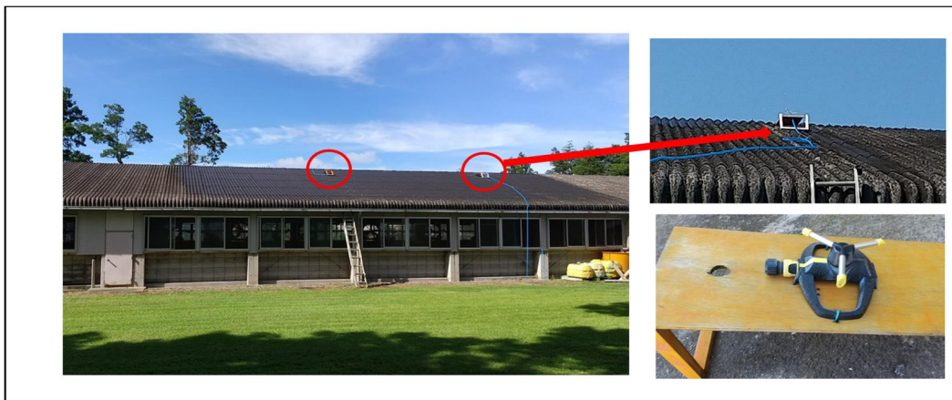
図1 園芸用スプリンクラーによる屋根散水(2台設置)
