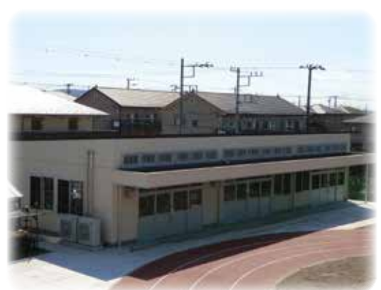
【作業棟の増築による対応】 (君津特別支援学校)
