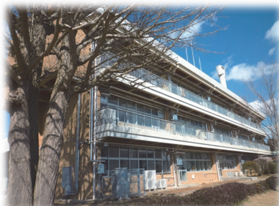
【旧市立小学校の校舎を活用した新設校】 (飯高特別支援学校)
