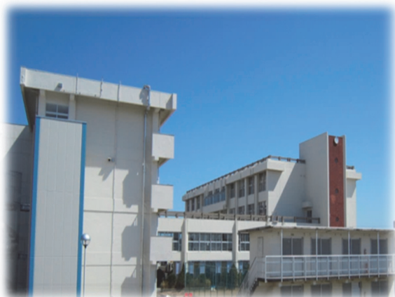
【旧県立高等学校の校舎を活用した新設校】 (大網白里特別支援学校)
