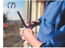
●ガラス面下部のスクイジーの引き方
