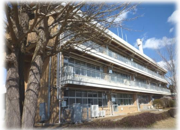
【旧市立小学校の校舎を活用した新設校】 (飯高特別支援学校)
