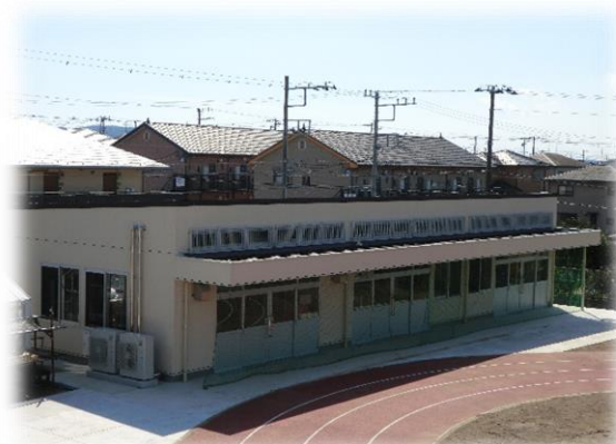
【作業棟の増築による対応】 （君津特別支援学校）
