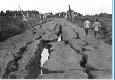
【液化化による館山市北条海岸の地割れ】液化化によって道路に地割れが発生し、多量の水や砂、泥を噴出ししました。「土木工事調査報告書」(物部, 1926) より引用
