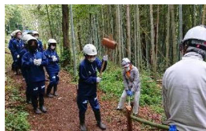
遊歩道整備のための杭打ち
