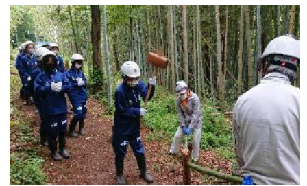
遊歩道整備のための杭打ち
