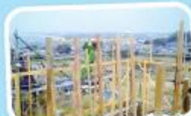
おやじの会は、クレーン車等を一切使用せず、手作業のみで展望台を完成させました。
