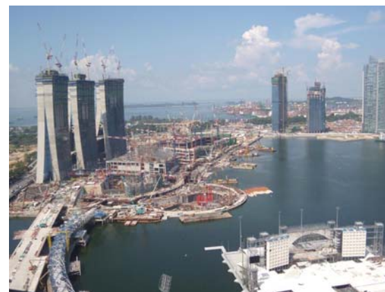
シンガポールのカジノ(建設中) 【統合リゾート計画】
