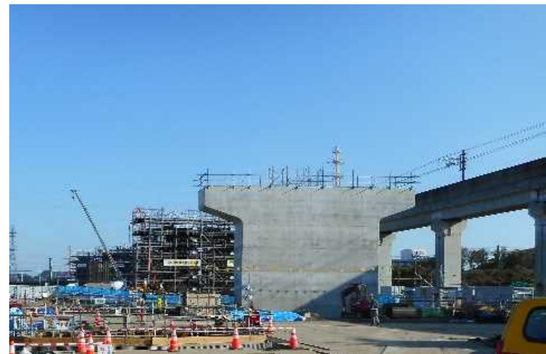
【国道464号 北千葉道路】
