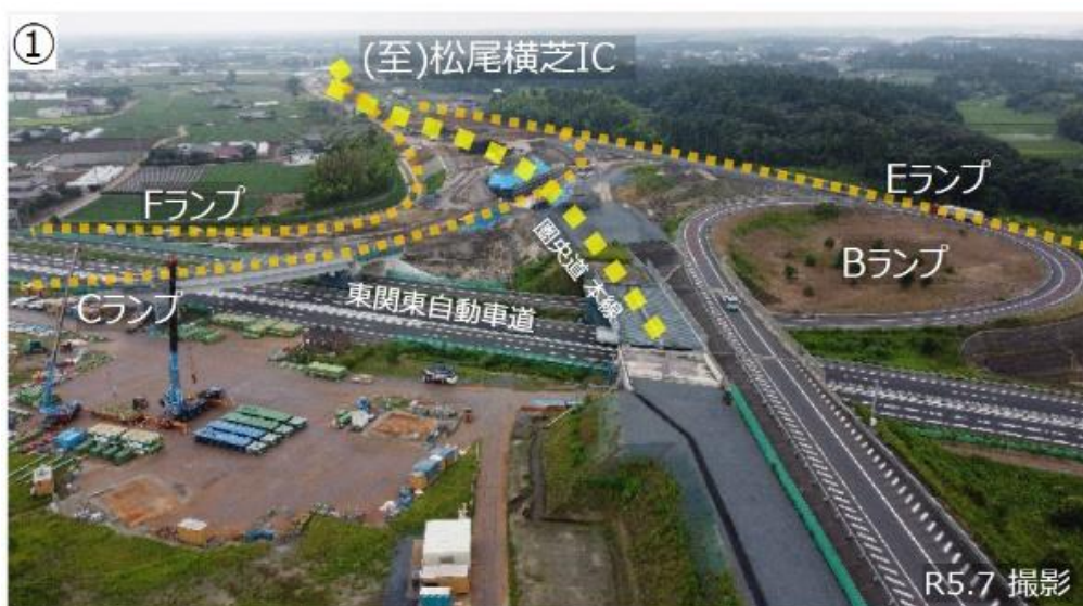
【図表】圏央道（大栄 JCT 付近）の整備状況
