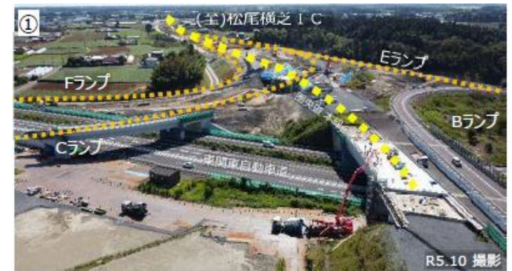
圏央道（大栄JCT付近）の整備状況 出典：国土交通省HP
