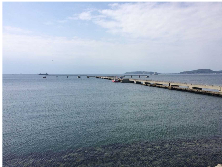
館山多目的棧橋
