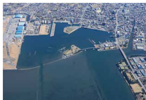
平成29年 木更津港吾妻地区
