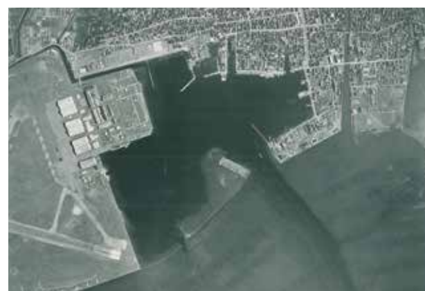
昭和36年 木更津港吾妻地区
