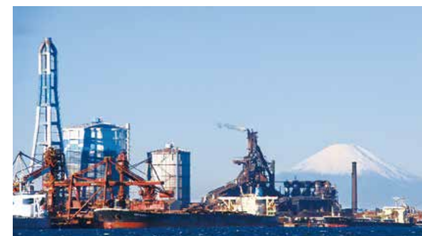
日本製鉄(株)東日本製鉄所 君津地区
