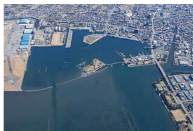
平成29年 木更津港吾妻地区
