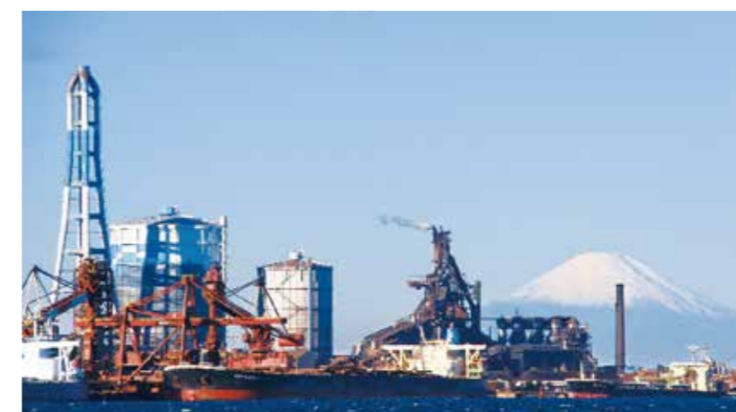
日本製鉄(株)東日本製鉄所 君津地区
