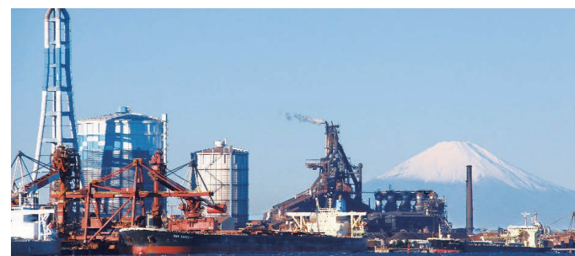
日本製鉄(株)東日本製鉄所 君津地区
