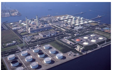
火力発電所 Thermal Power Station
