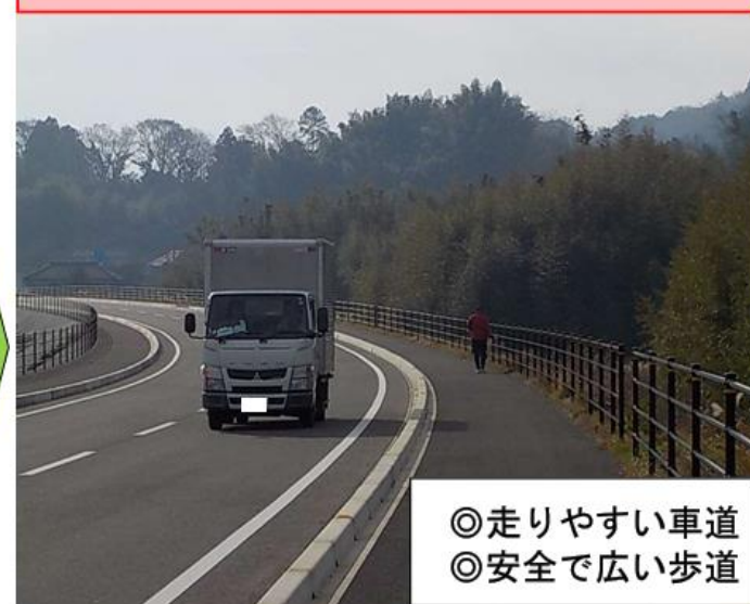
国道410号久留里馬來田バイパス
