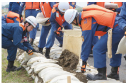
浸水被害拡大を防ぐ土のう積み
