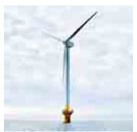
銚子沖の洋上風力発電
