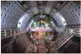
海底トンネル工事の様子 (提供:東京湾横断道路株式会社)
