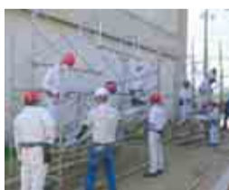
足場組み立ての実習
