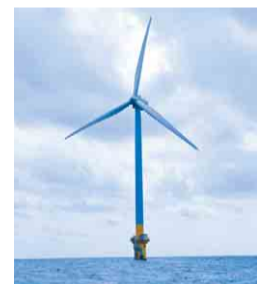
銚子沖の洋上風力発電
