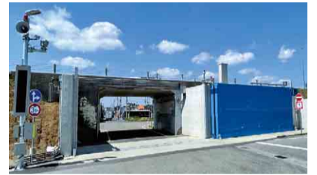
九十九里町不動堂の陸閘
